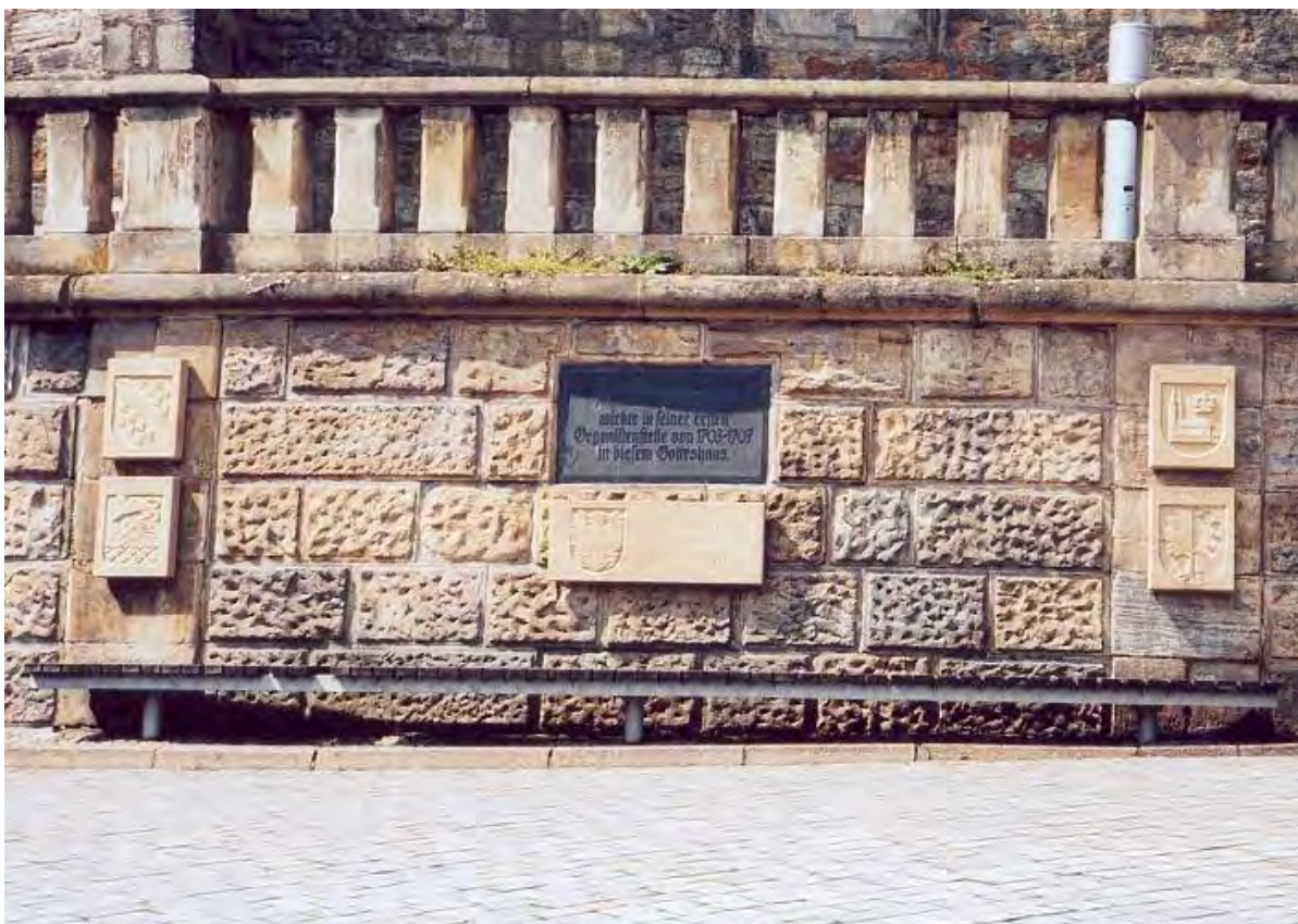
Balustrade an der Bachkirche
