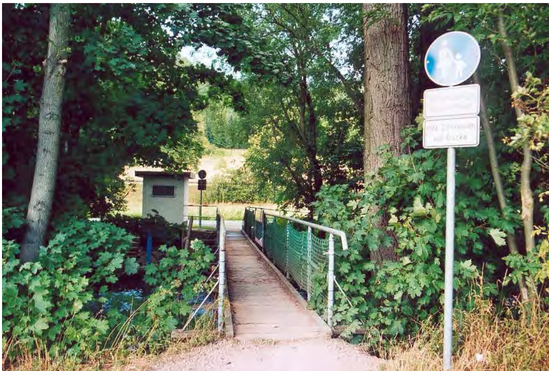
Nach dem Unfall wurden hier Fangnetze angebracht.
